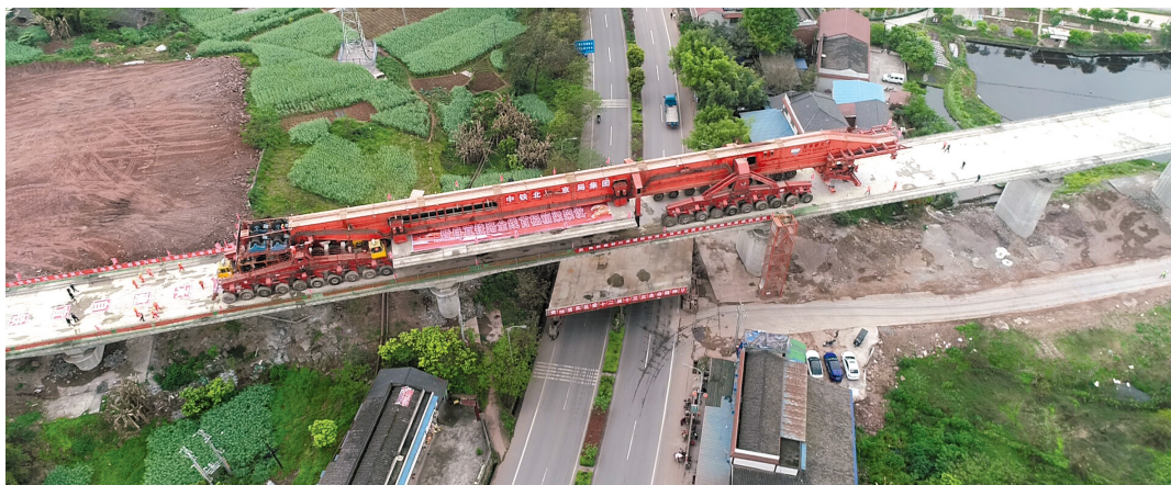
航拍箱梁架设。
