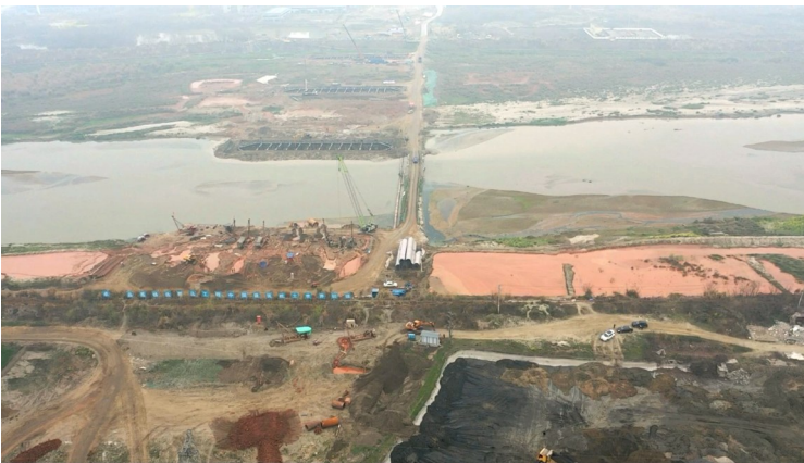
天府大道北延线(德阳段)施工现场。
