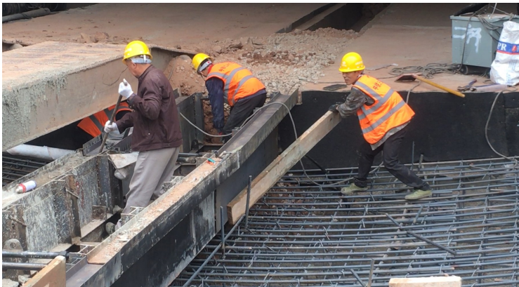
梓潼县掀起交通建设热潮,工人们正加紧施工。
