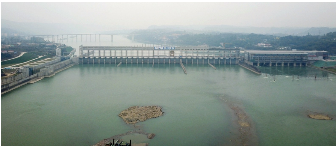
犍为航电枢纽主体基本完工。
