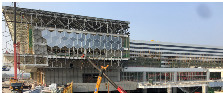
建设中的川南城际铁路自贡东站。
