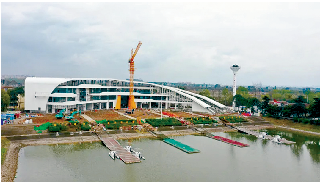
大运会赛艇场馆已基本完工。
