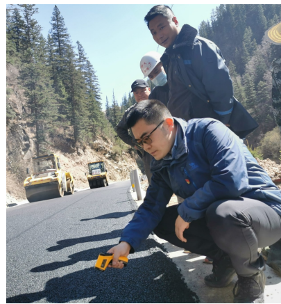
赵煜民查看公路修建情况。图据受访者
