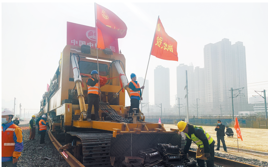
川南城际铁路内自泸线最后一公里铺轨现场。
