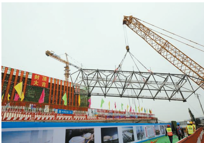
1月30日,成都大运会剧院项目正在进行屋面钢网架吊装。曾浩 摄
