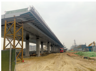
改造工程施工现场。
