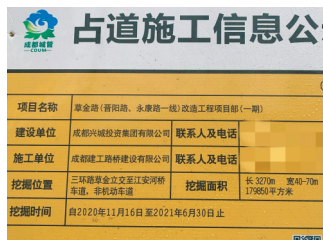
占道施工信息公示牌。
