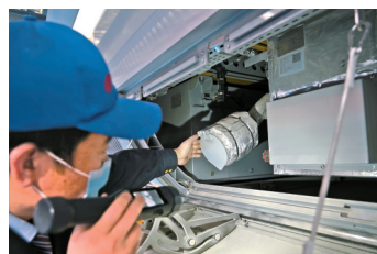
工作人员在检修新型高寒动车组水箱注水口,水管表面由防寒材料覆盖。
