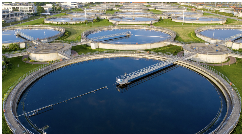
成都市第九再生水厂完成提标改造,实现通水调试。
