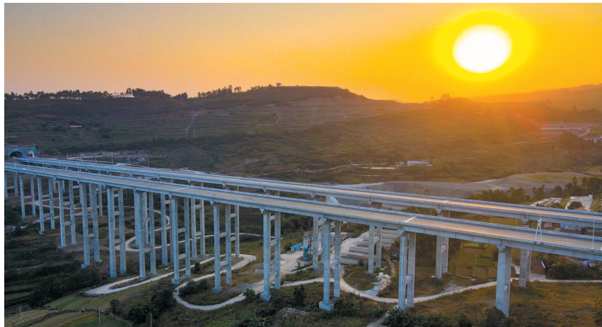
成宜高速五皇坝大桥。
