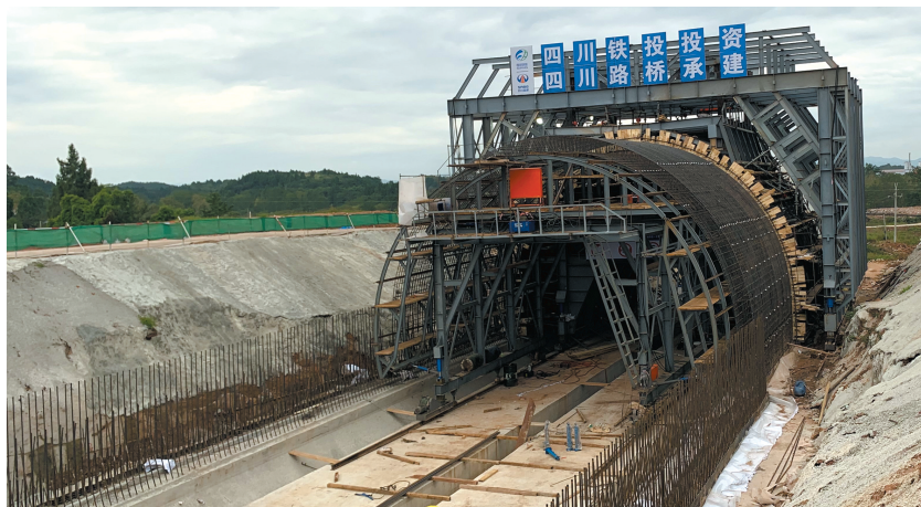
成自高铁天府机场下穿隧道拱顶暴露在外。
