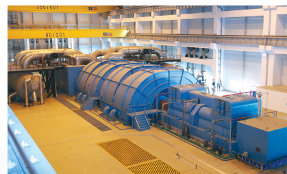
“华龙一号”全球首堆福清核电5号机组常规岛厂房(11月26日摄)。新华社发
