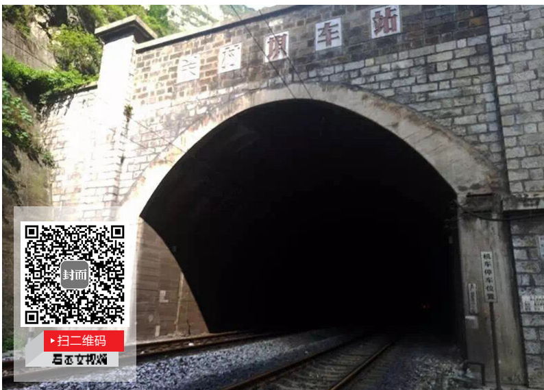
关村坝站是中国第一个建在隧道里的火车站。
