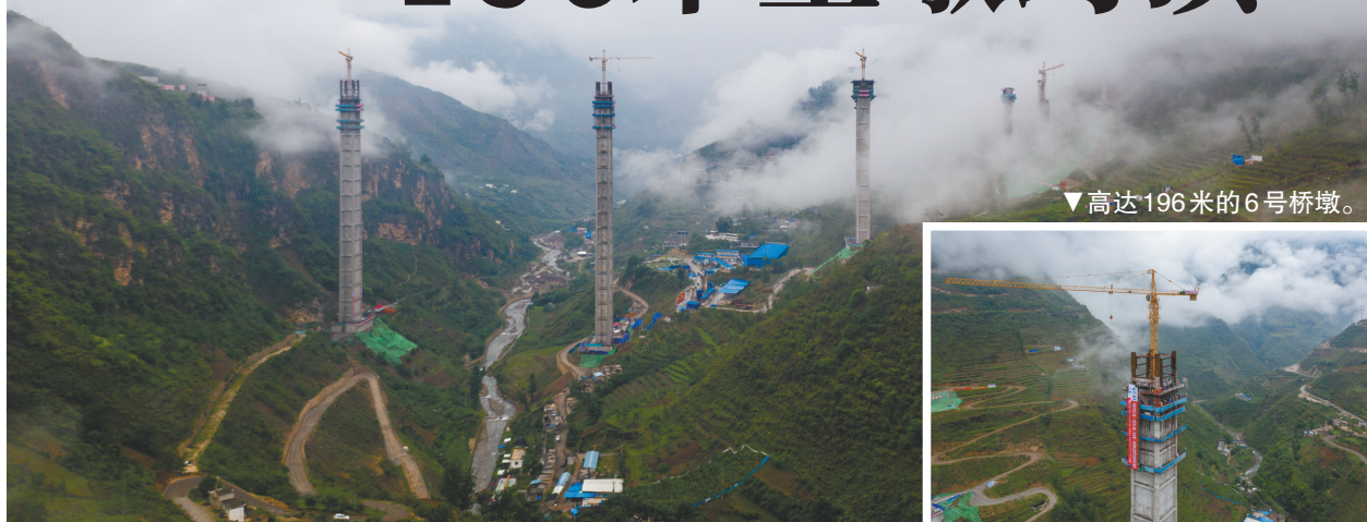
▲6月23日,凉山彝族自治州金阳县,金阳河特大桥高达196米的主墩顺利封顶。
