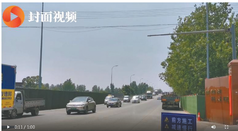
成都大件路绕城跨线桥将由双向四车道拓宽到双向八车道。
