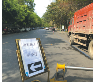
施工区域竖起指示牌，请车辆绕行。
