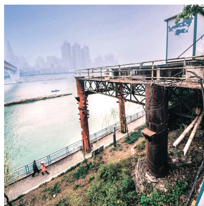
残存下来昔日码头的设施。
