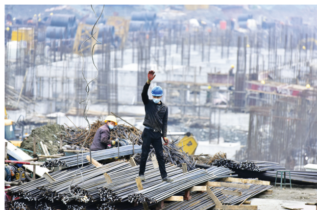
都江堰华瑞医院工地上,一名工人指挥吊装。 邹亮初摄
