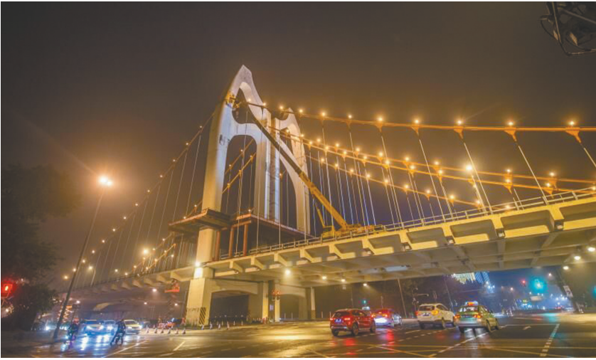
对清水河悬索桥实施加固整治工程。
