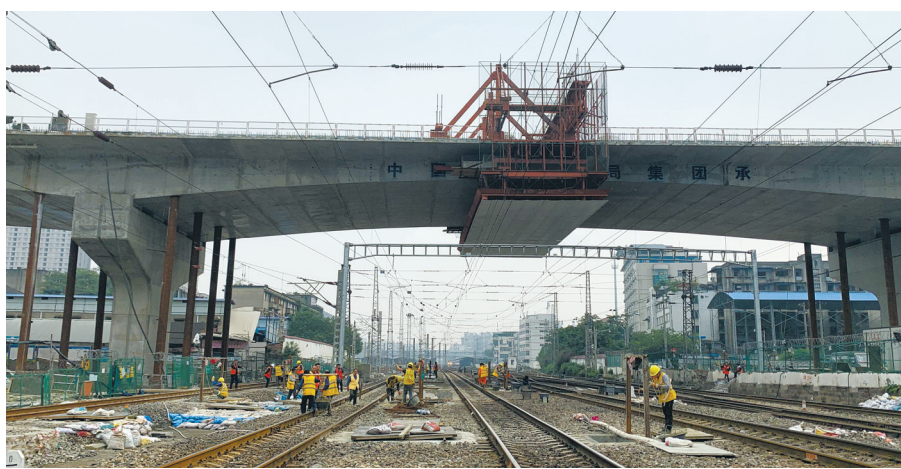
成都火车北站商贸大道跨铁路立交合龙。商贸大道开通后,五块石片区进一环只需要三五分钟。
