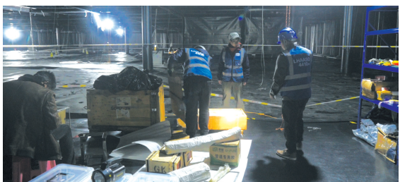
探测器安装现场。
