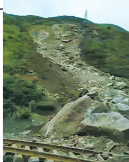
14日岩体崩塌现场。
