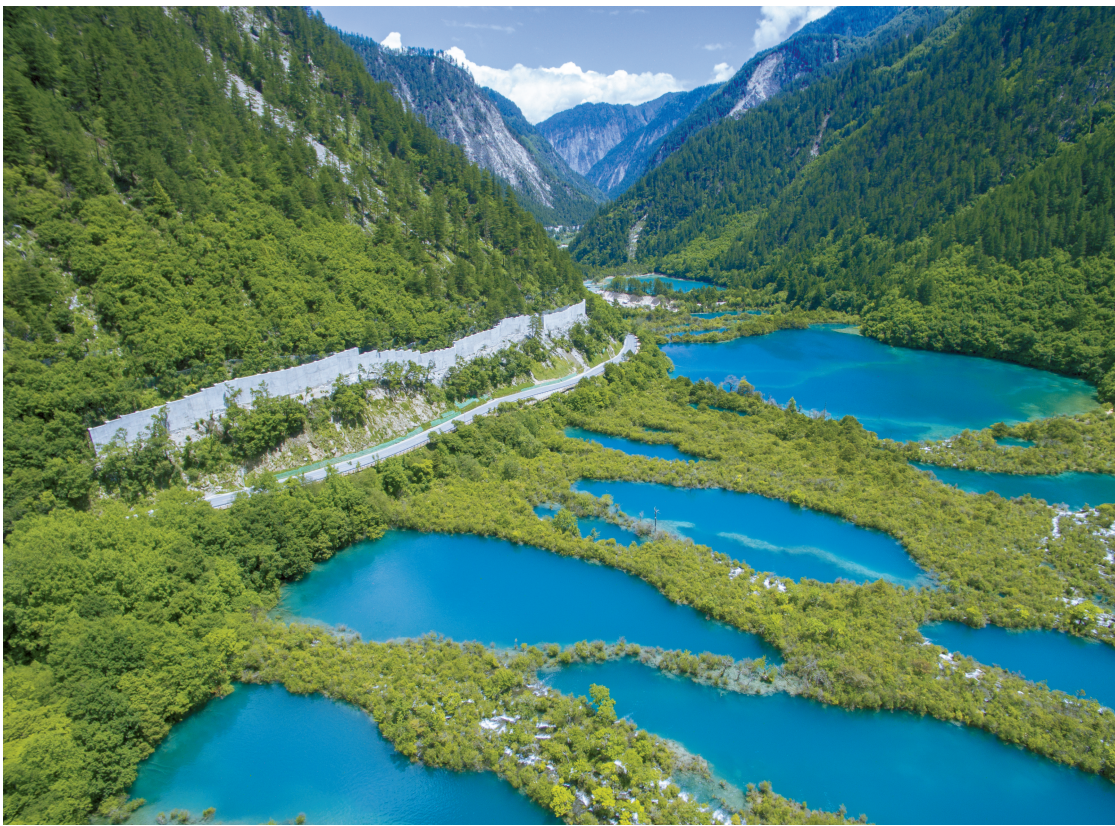
▲ 树正群海新貌。左侧山脚新建有桩板拦石墙。
