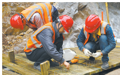
工人正在进行栈道施工。
