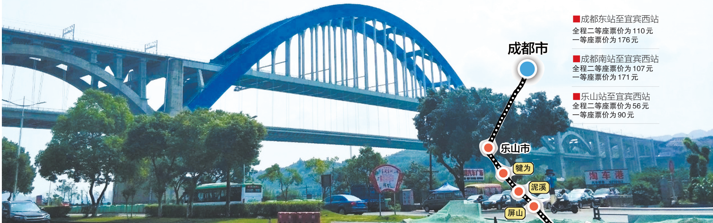
从宜宾西站候车室可看到成贵铁路上壮观的金沙江公铁两用大桥。图据网络
