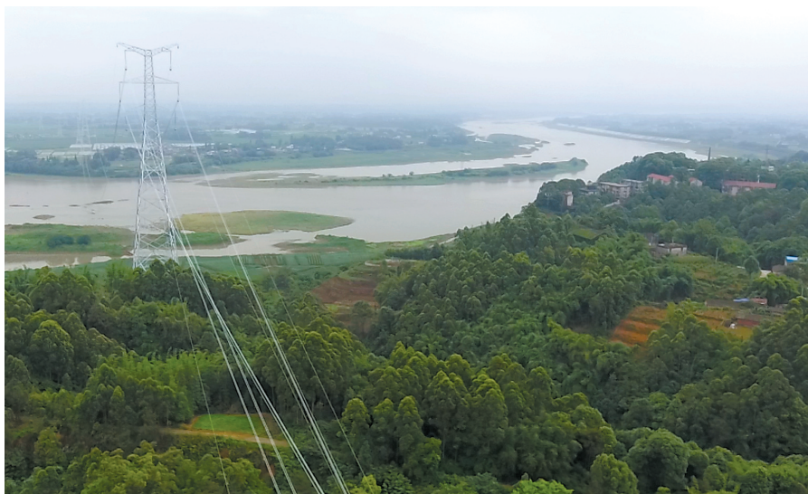
超高压线横跨岷江航道。
