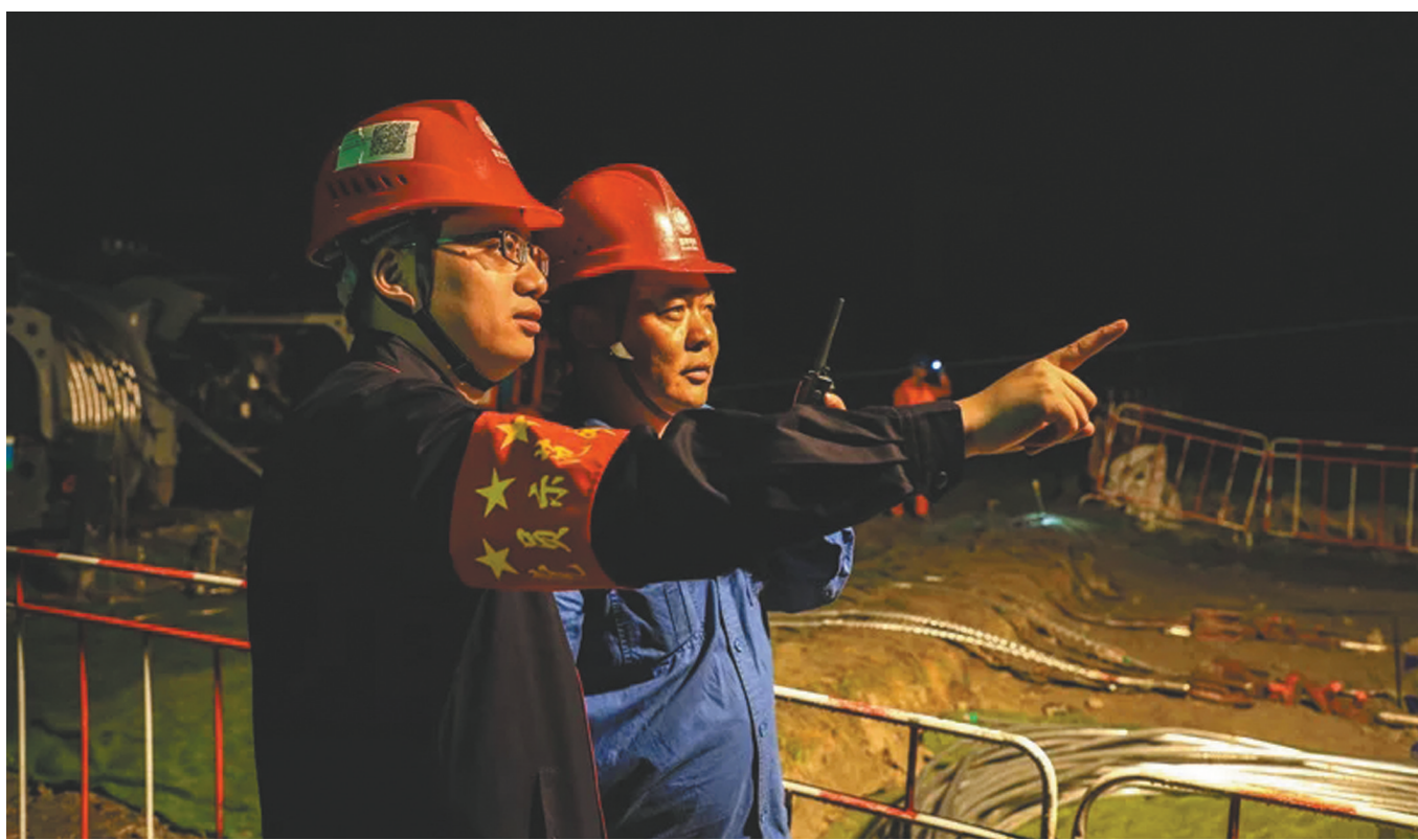
刘嘉(左)在夜间施工现场查看。
