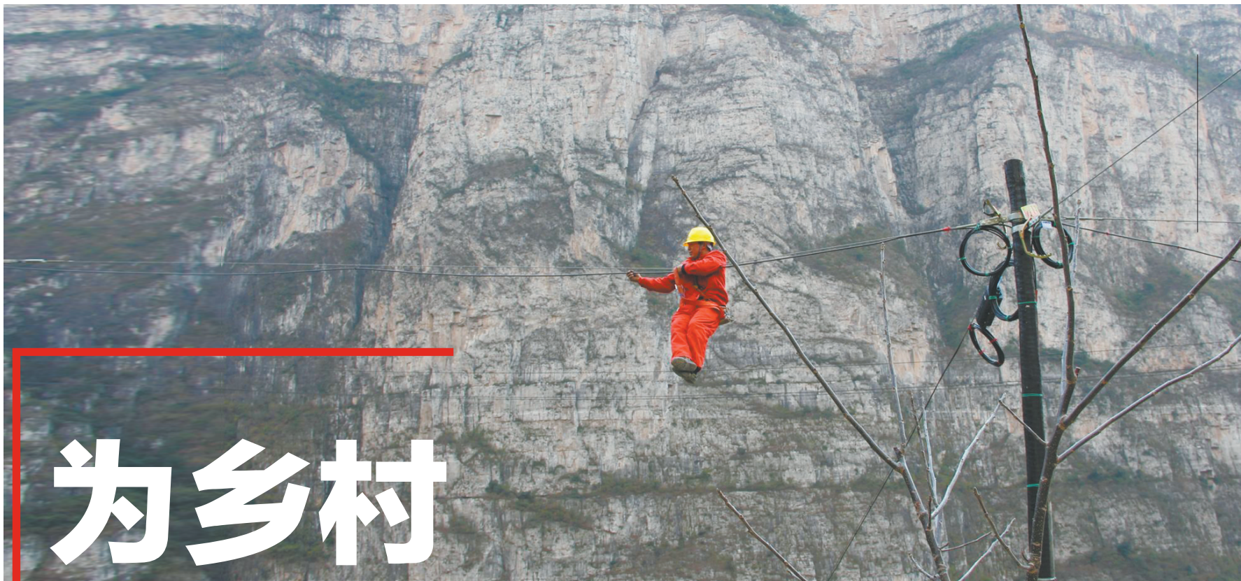
通信建设人员正在高空架设光缆。
