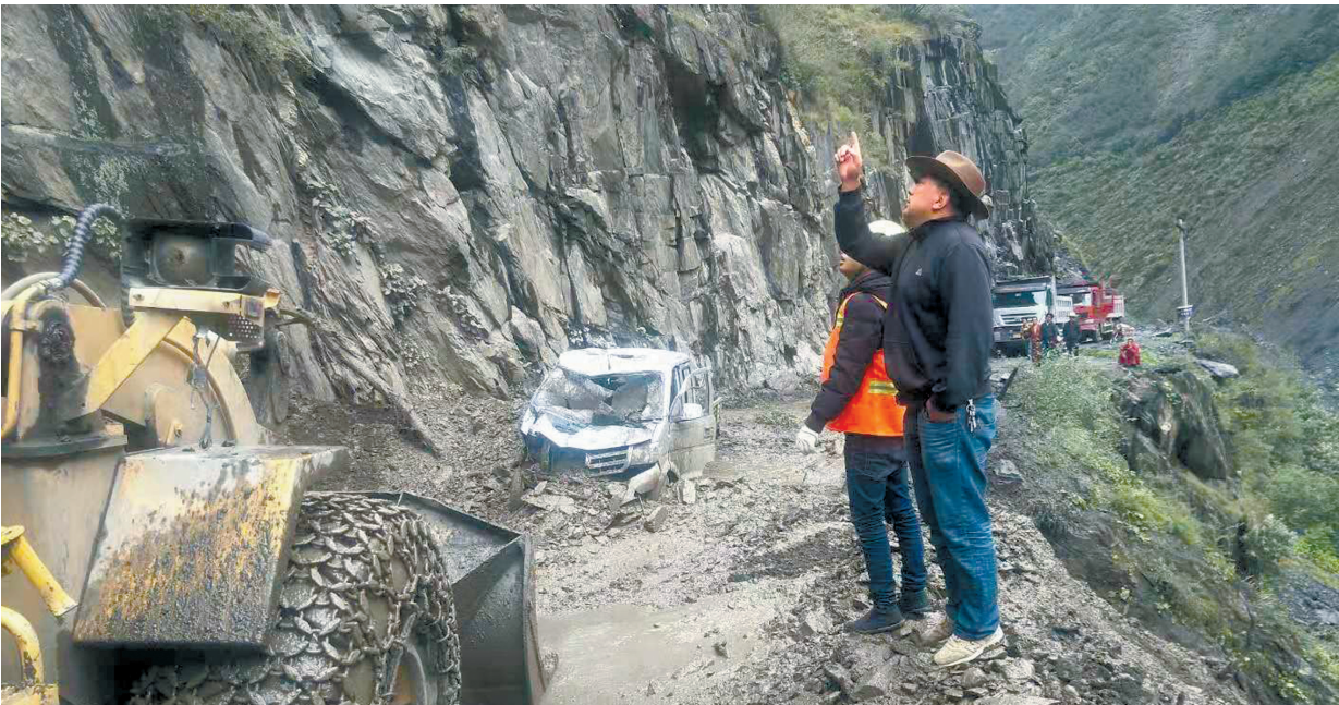
一旦路遇塌方或泥石流,胡德伟就会带领人员,开着装载机奔向现场排险抢修。(受访者供图)
