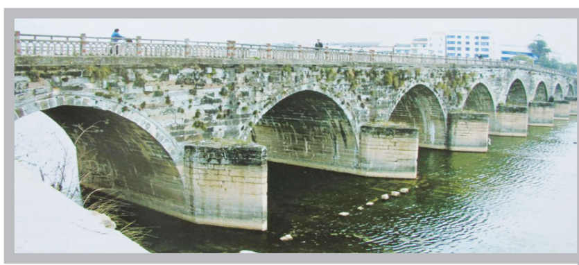
梓潼县天仙桥。梓潼县崇文塔。
