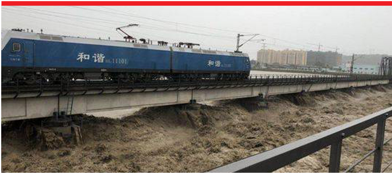
今年7月11日,绵阳连续强降雨,两列超过45节编组的重载列车,用自身的重量压住大桥,保住了宝成铁路。
