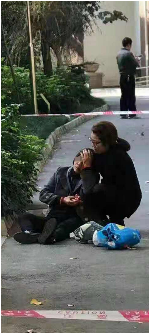
小区外墙砖脱落砸伤业主。
