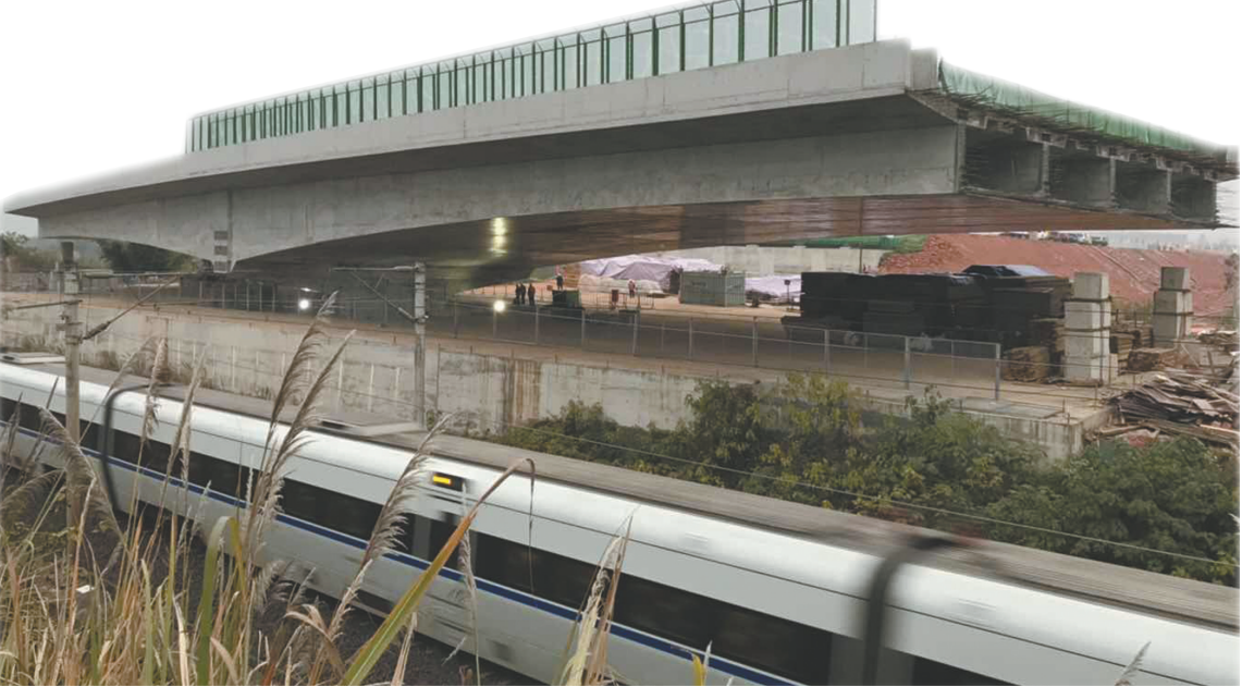
沪蓉铁路旁,浇筑完毕等待转体的上跨转体桥。
