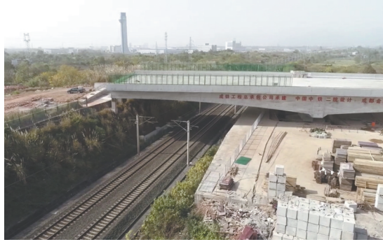
完成转体后上跨沪蓉铁路的大桥。
