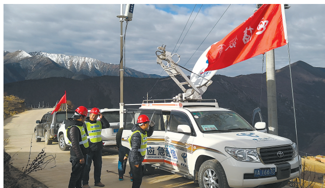
白玉县电信公司在一线设立移动通信信号基站。
