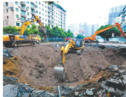
救援现场，大型机械正在作业。
