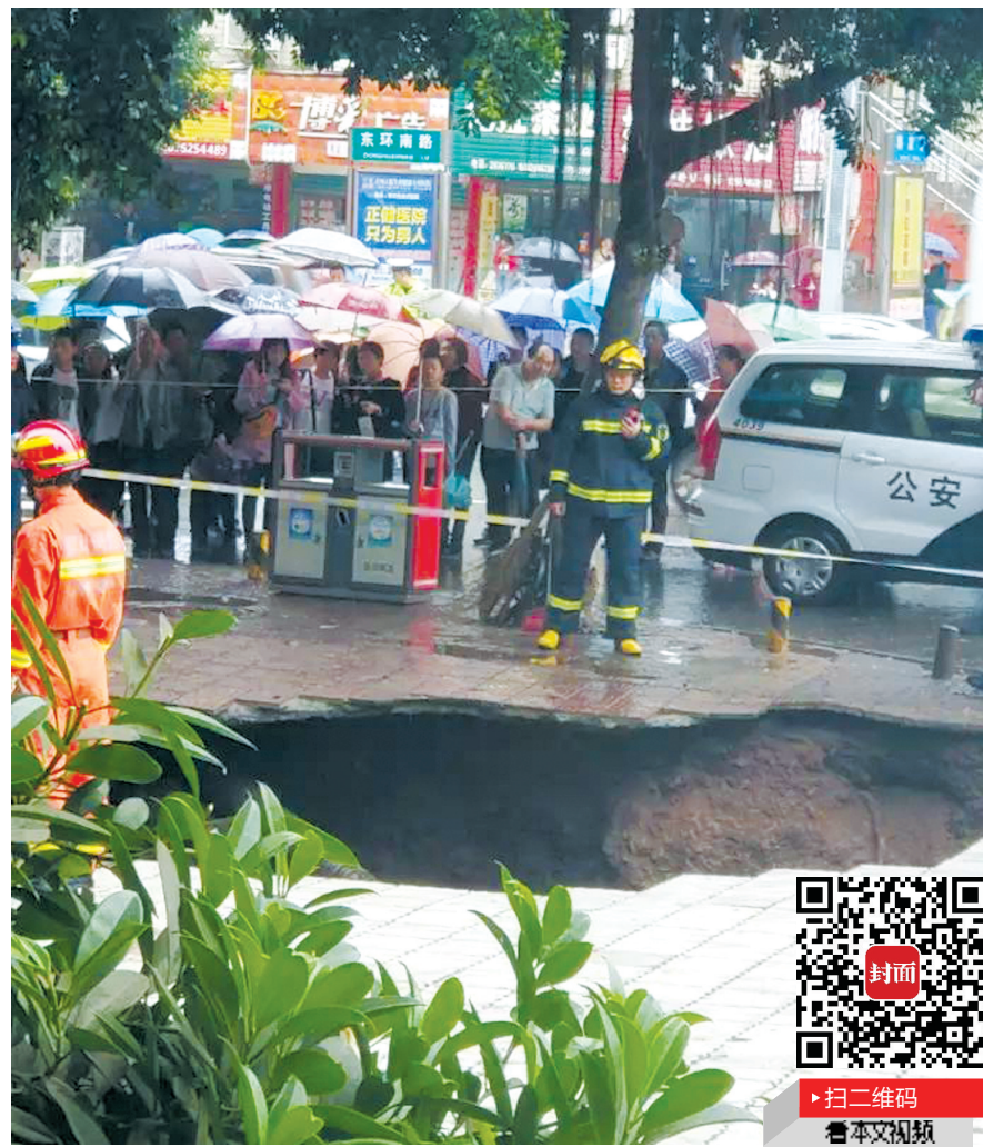
垮塌现场。(网友供图)
