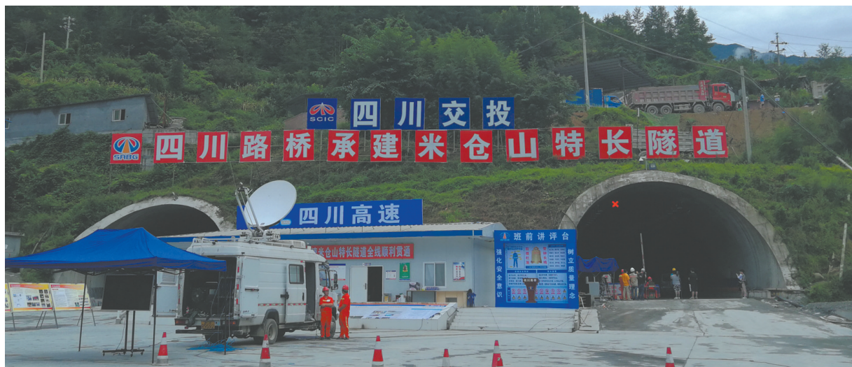
四川第一、中国第二长的特长隧道米仓山隧道9日贯通。
