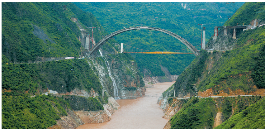
从博南山上下来，就到了澜沧江边。澜沧江上，架着三道大桥，最高的大保铁路桥，黄色的是输油管道桥，最低的铁索桥是彩虹桥。
