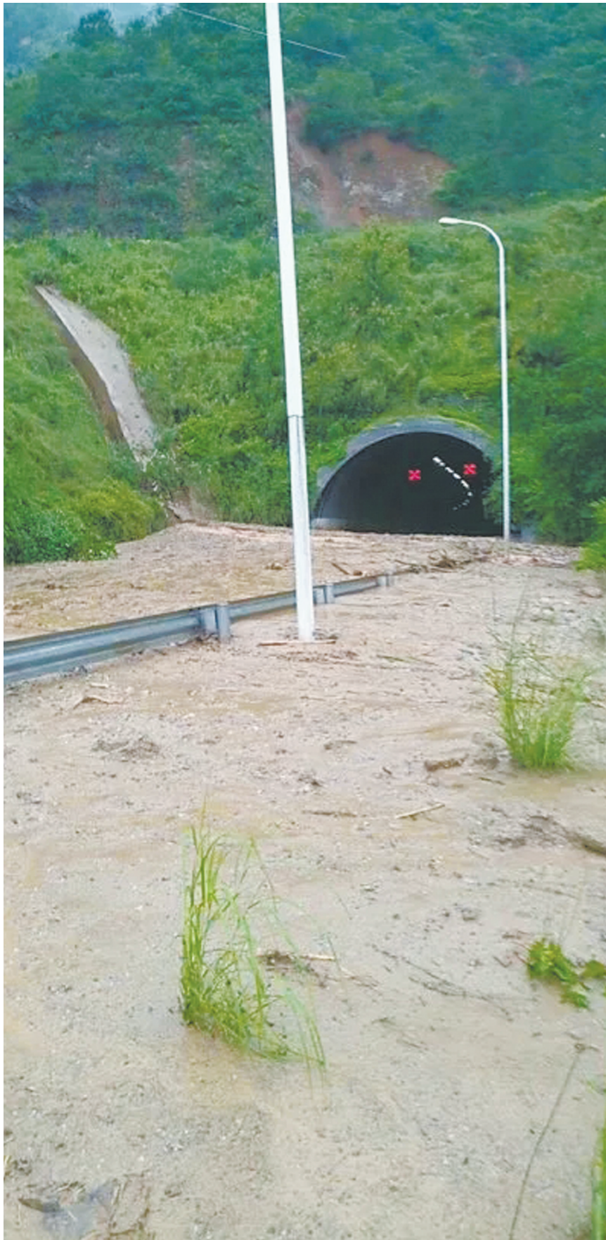
石棉隧道口附近山体滑坡，泥石流冲进隧道内。
