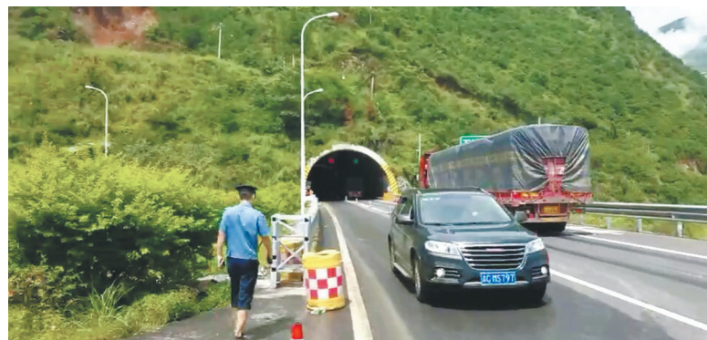
目前，石棉隧道口已恢复单幅双向通行。
