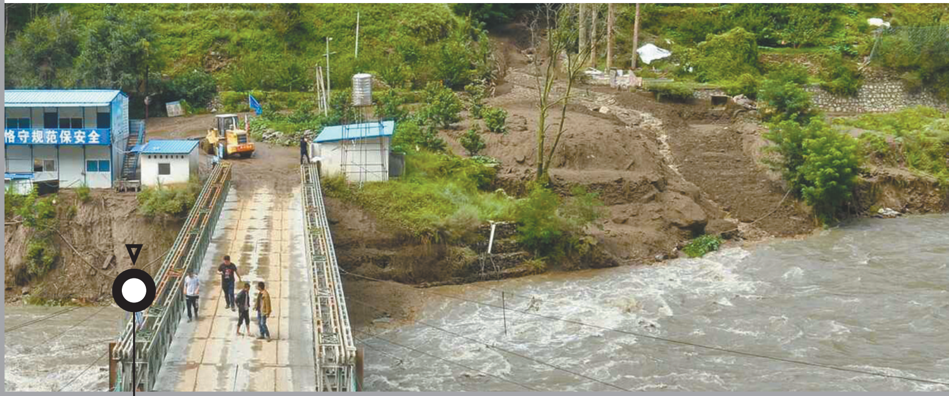
被泥石流阻断的道路在紧张抢通中。
