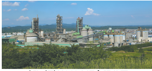
都江堰拉法基水泥有限公司
