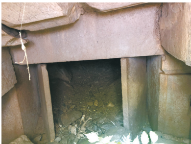
回字形墓穴内部。
