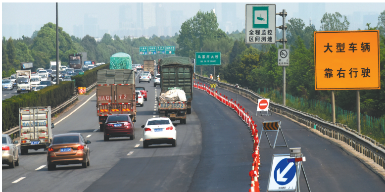
整治后的绕城高速公路路面。
