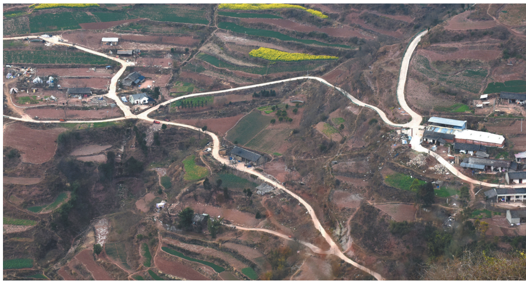
从高处俯瞰，金堂县境内农村公路已串联成网，非常便捷。
