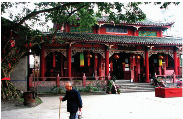
木城镇保存完好的清代雕花建筑。图据成都时光
