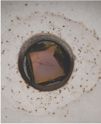
土圆仓的穹顶设计利于排水；穹顶最上方和圆形墙体高处分别建有通风窗口。
