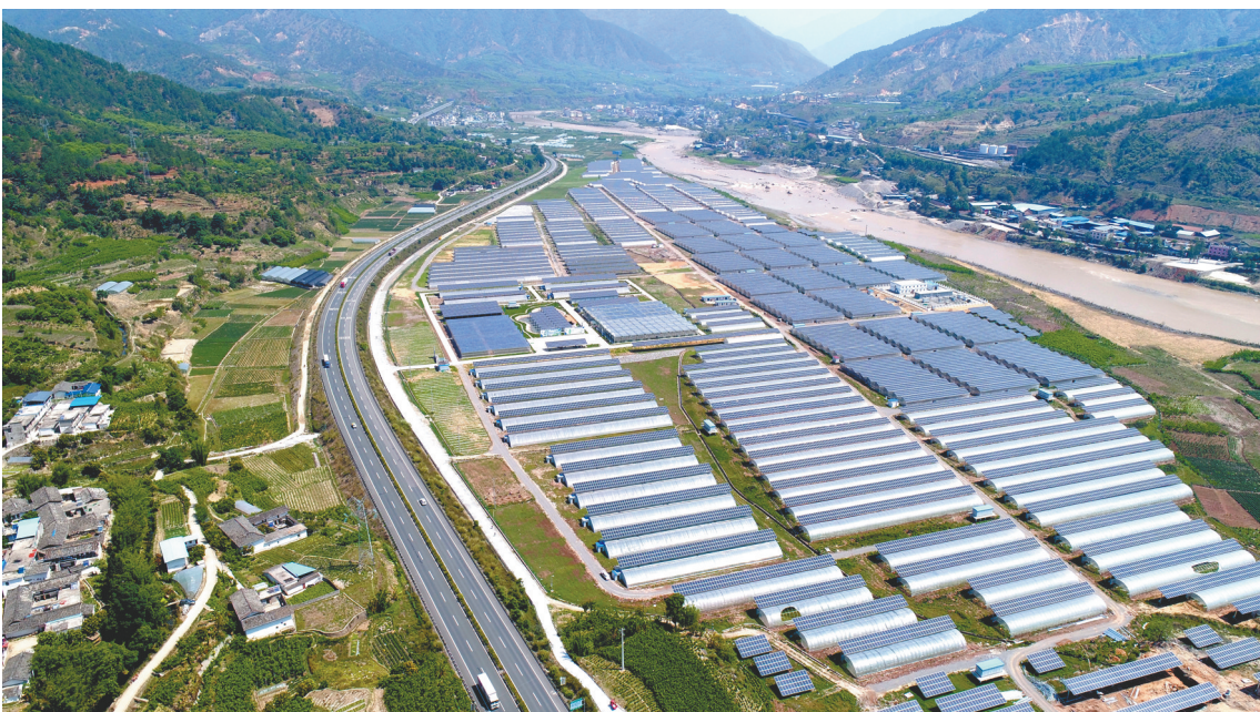
凉山德昌光伏农业科技示范产业园。宋明摄
