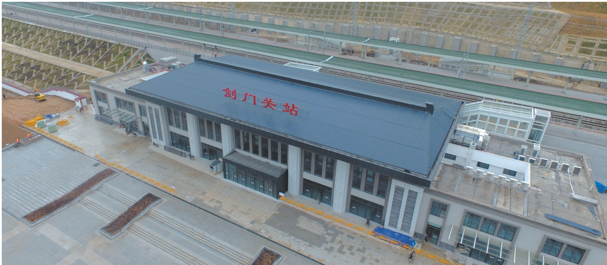
剑门关车站站房主体已完工。
