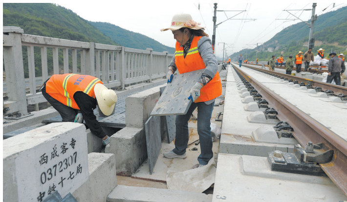
嘉陵江特大桥，工人正在紧张施工。
