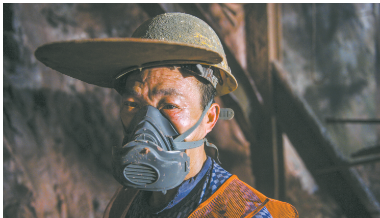
施工隧道尽头温度高,汗水打湿施工工人工作服。
