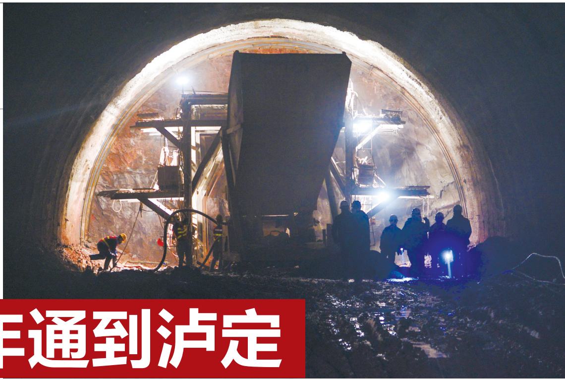
2月5日,飞仙关特长隧道施工现场,一台巨大的喷浆机正在工作。
